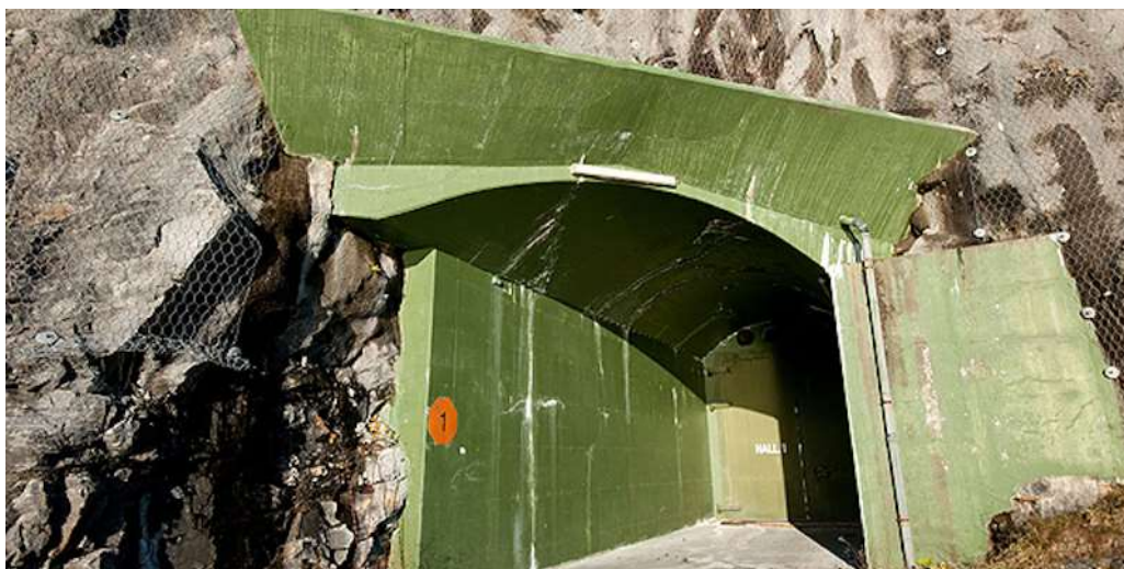
Вход в дата-центр
