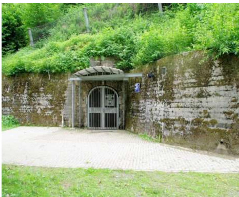
Вход в хранилище Барбараштоллен
