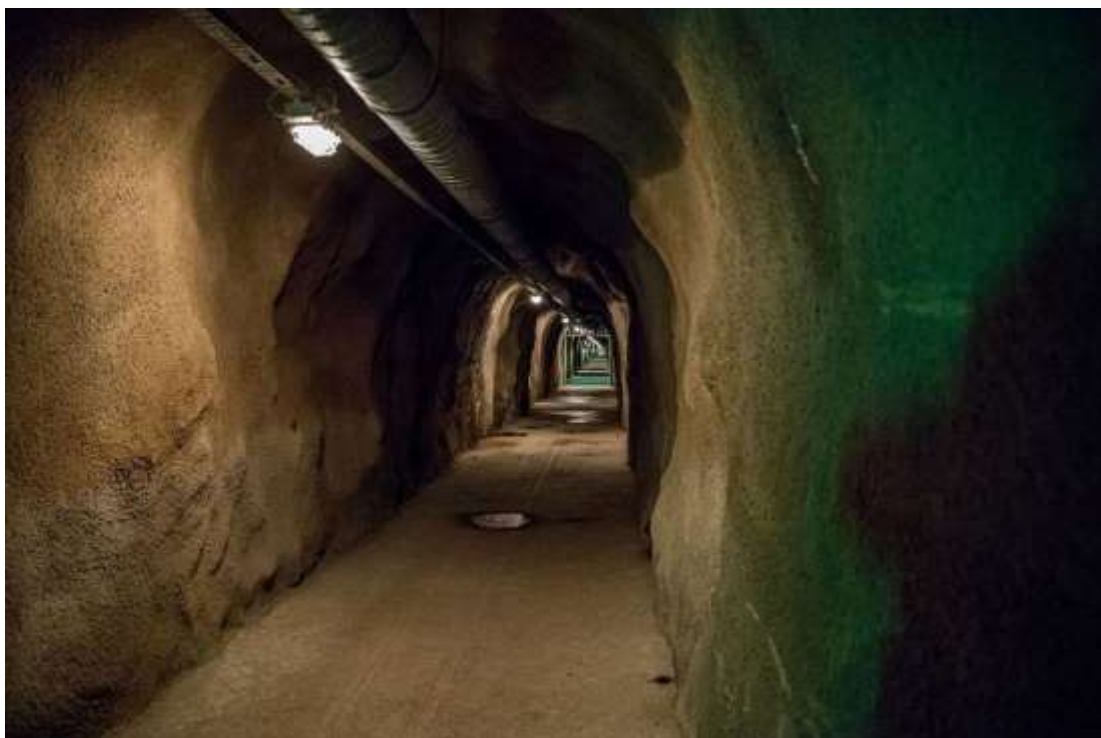
Основной тоннель хранилища
